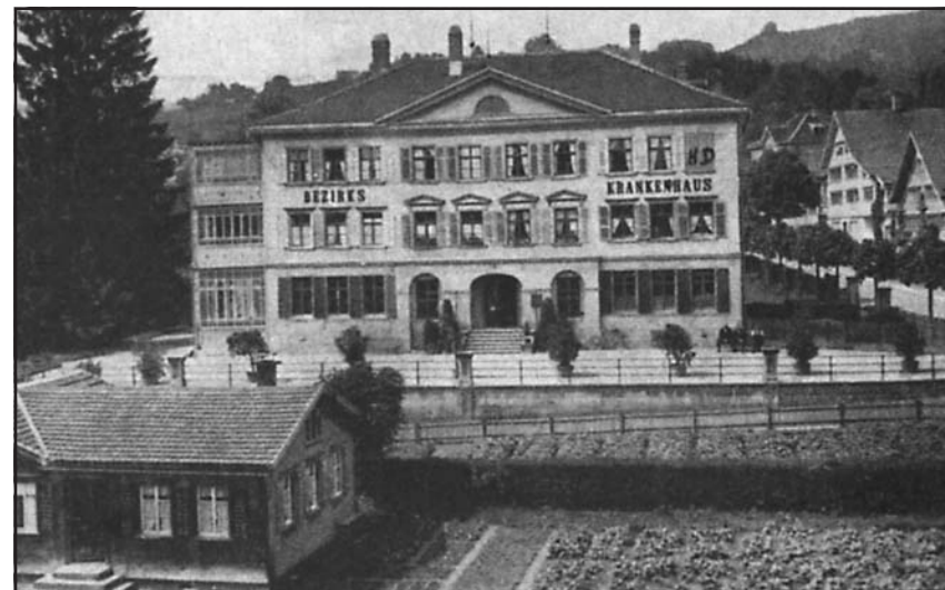
Nemocnice v Heidenu
